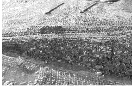
図12 今津地先における被覆網内の砂堆積状況 (砂の堆積が顕著)
