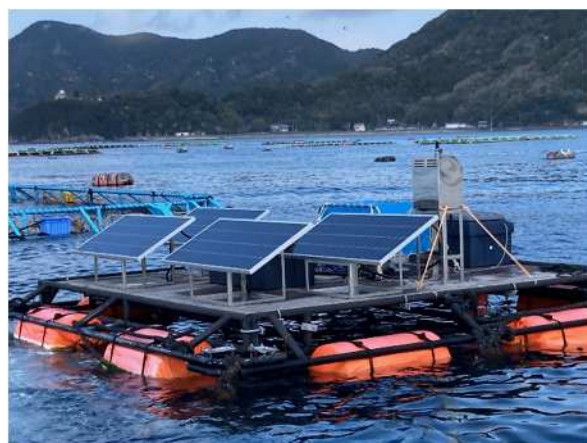
図 2 電源筏（筏：畑野製作所製、電源部分一式：環境システム株式会社製）
