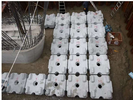
根固め工 (設置状況)
