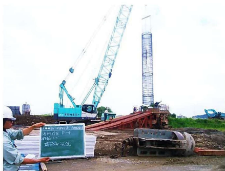
場所打ち杭工 (杭鉄筋吊込み状況)
