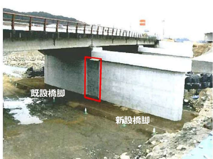
隔壁工 (設置状況)
