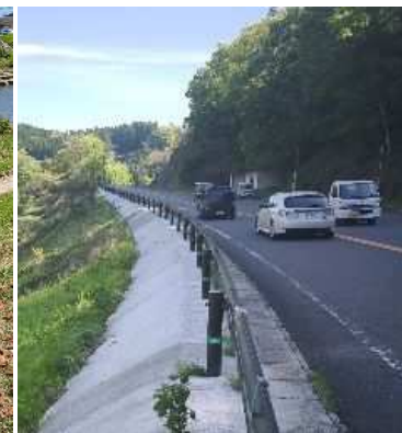
道路のり面の防草対策 国道502号（豊後大野市）
