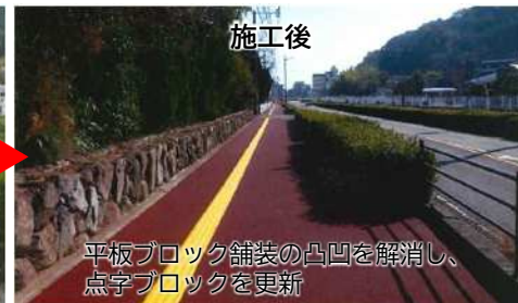
歩道面段差解消、視覚障がい者誘導用標示（点字ブロック）更新 鉄輪亀川線（別府市）
