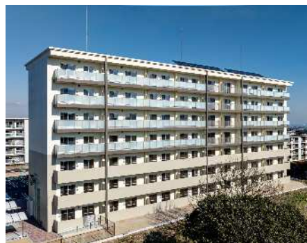
完成した県営明野住宅 HRR-5棟(大分市)
