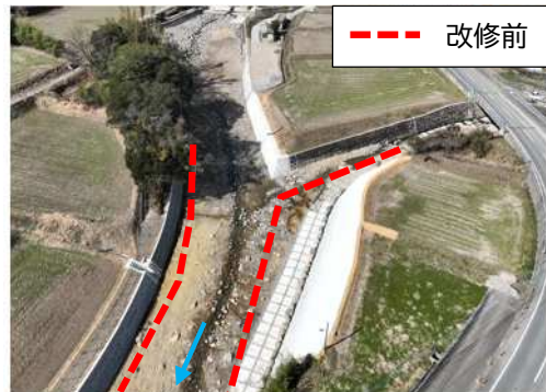
小野川：河川拡幅工事（日田市）
