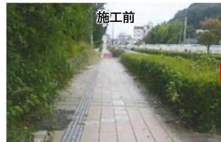
歩道面段差解消、視覚障がい者誘導用標示（点字ブロック）更新 鉄輪亀川線（別府市）
