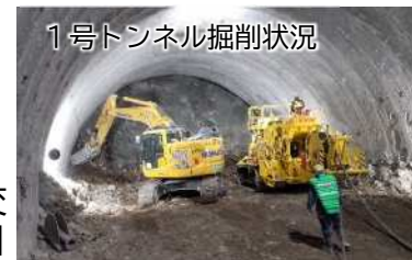
1号トンネル掘削状況
