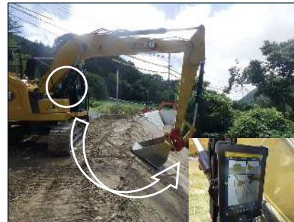
ICT活用工事実施状況（国東市）
