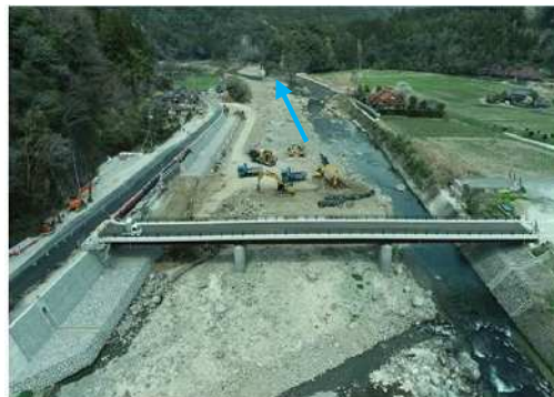
山国川：諏訪橋の架替工事（中津市）
