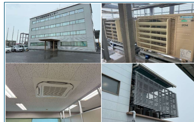
管理棟の省エネルギー（空調設備）
