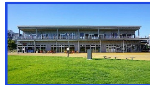
© ACTIVE COMMUNITY PARK 【芝生ひろば側の商業施設】
