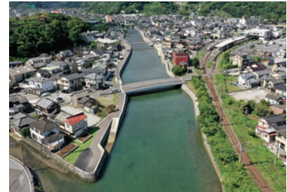
河川改修が完了した津久見川
