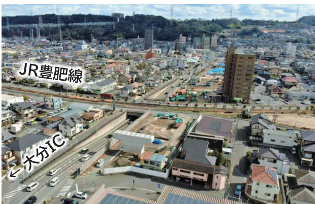
庄の原佐野線（下郡工区）整備状況
