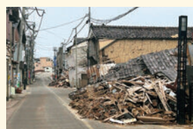
能登半島地震による被害状況
