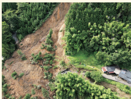
ドローンによる被災箇所調査
