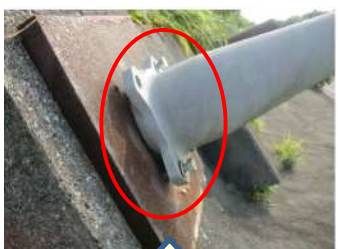
頭部キャップボルト 緩み・欠損
