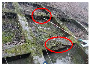
破損・鉄筋の露出
