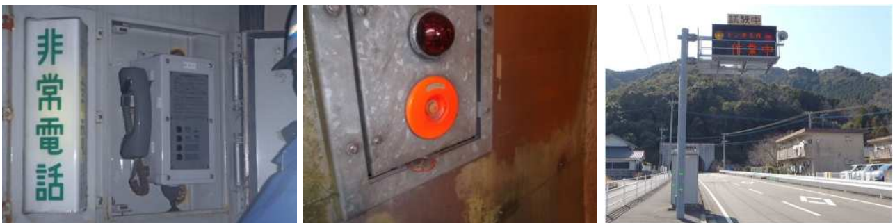
図14 非常電話、押しボタン式通報装置、警報表示板
