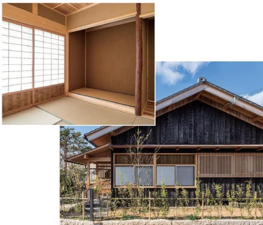
片面真壁造の土塗壁（写真 4）
