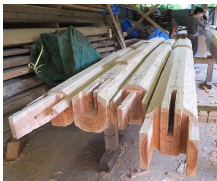
手加工による継手仕口（写真6）
