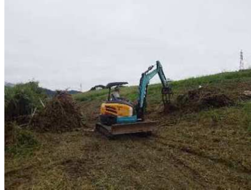
大分川 滝尾橋下流左岸
