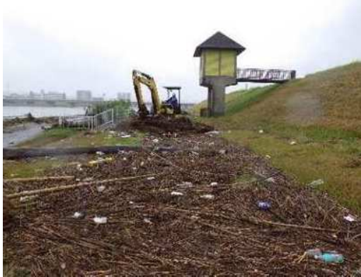
大野川 大野川橋上流左岸
