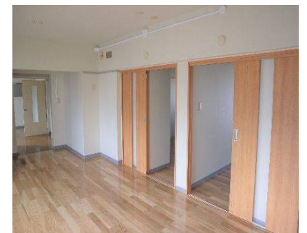
子育て世帯向け住戸整備 子どもの見守りがしやすい間取りの改修状況
