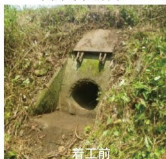
長寿命化計画に基づき更新した樋門（臼杵市）
