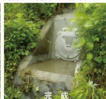
長寿命化計画に基づき更新した樋門（臼杵市）
