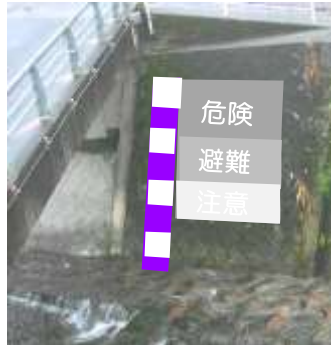
〔設置後(通常時)〕
