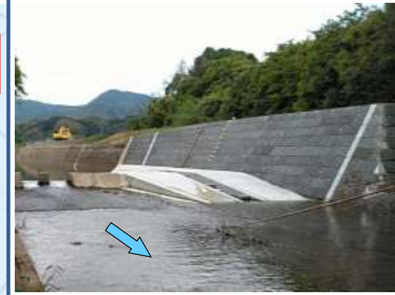
熊崎川(整備中写真)
