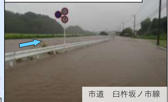
熊崎川 浸水状況 (H23.9)
