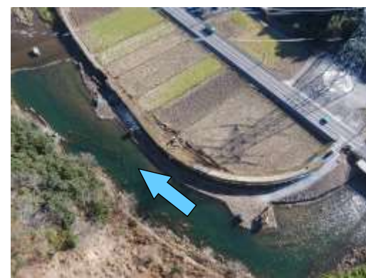
臼杵川(整備中區間)
