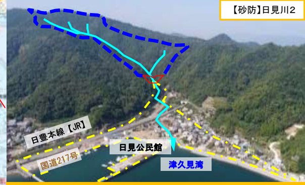
砂防設備の整備
