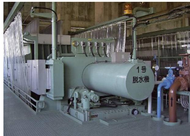
加圧脱水機(汚泥処理設備)
