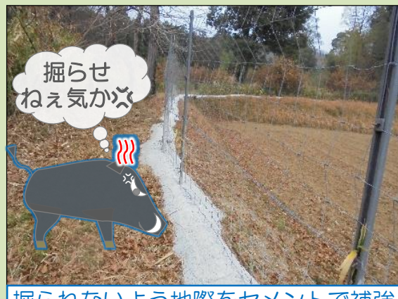
掘られないよう地際をセメントで補強
