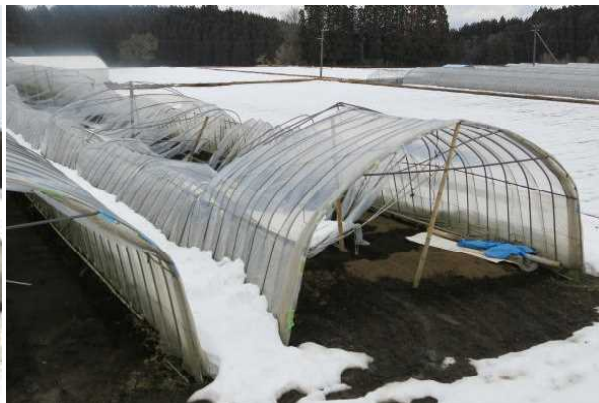
写真10 支柱のバランスが崩れて倒壊したハウス
