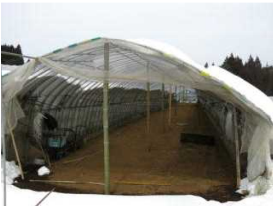
写真9 竹支柱により補強したハウス
