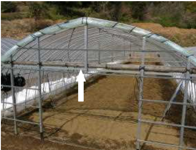
写真2 丸太により補強したハウス
