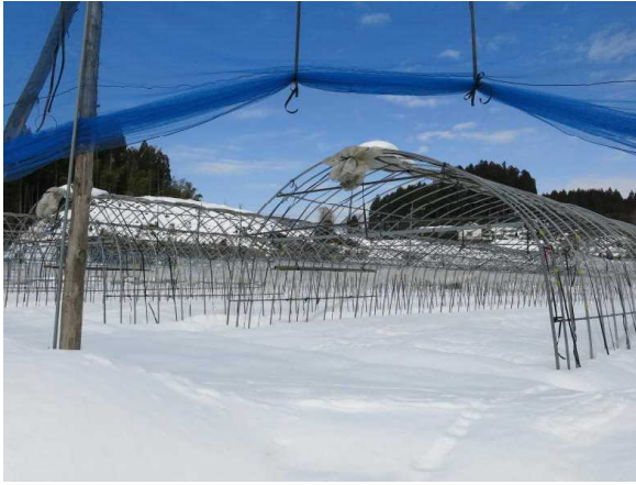
写真7 被覆ビニールを天井部に結びつけたハウス
