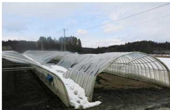
写真15 ネットを切断したハウス
