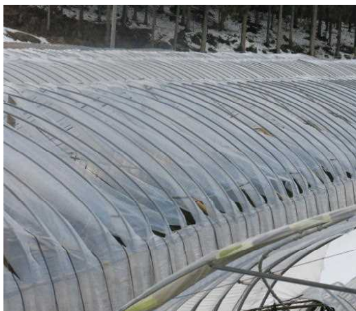
写真12 ビニールを切断したハウス
