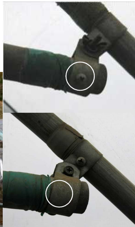
写真3 ボルトによる直管の補強
