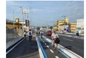
自転車通行空間の整備状況 （国道442号・大分市）
