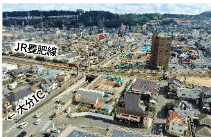
庄の原佐野線（下郡工区）整備状況
