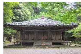
富貴寺大堂（現存する九州最古の木造建築物）
