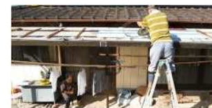
住民参加型福祉サービスによる屋根の補修
