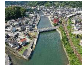
河川改修が完了した津久見川
