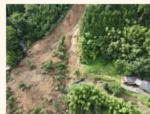
ドローンによる被災箇所調査
