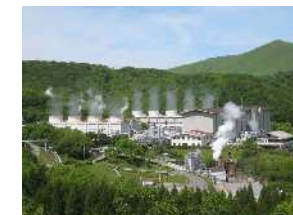
九州電力(株)八丁原発電所
