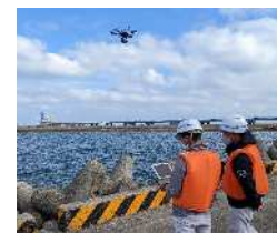
港湾施設点検におけるドローンの活用
