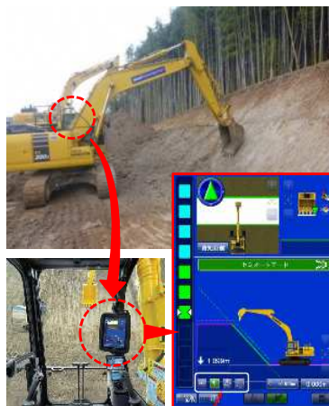
ICT建機での施工
