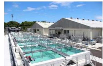
新たに整備した種苗生産施設
