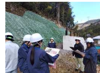
急傾斜地崩壊対策事業
