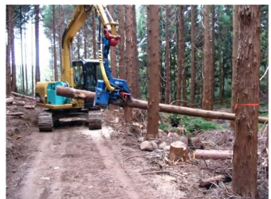
高性能林業機械による搬出間伐
