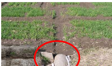
排水口のつまりを点検
