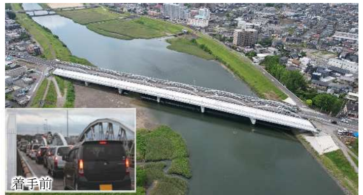
国道197号 (鶴崎拡幅) 進捗状況
