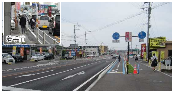
国道442号 (宗方拡幅) 一部供用済みの区間
