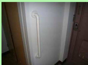
手すりの設置
