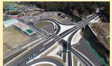
三光本耶馬溪道路 開通状況 (青の洞門・羅漢寺IC付近)
