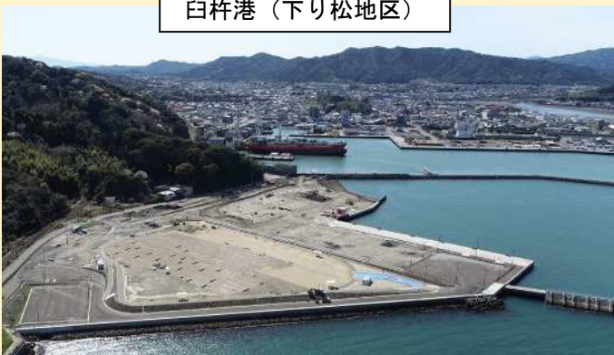
令和5年度実施 埠頭用地造成工
