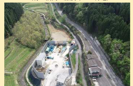
日田山国道路 整備状況
