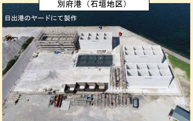
令和5年度実施 ケーソン製作工
