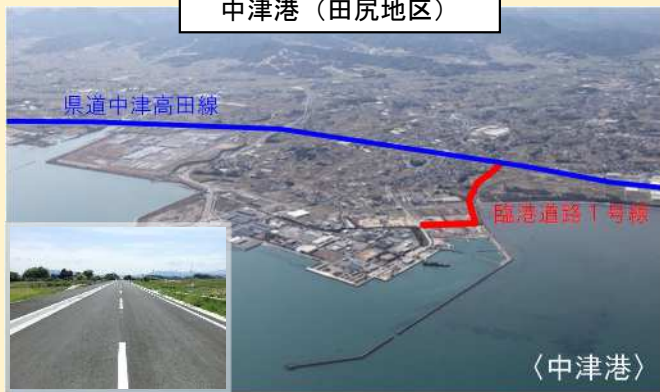
令和5年度実施 道路改良工
