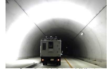
[レーザーと高解像カメラを搭載した専用車両による走行型のトンネル点検]
