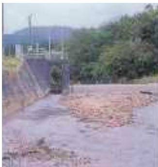
白水川取水堰
