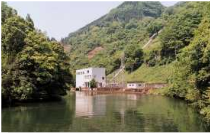
芹川第一発電所
