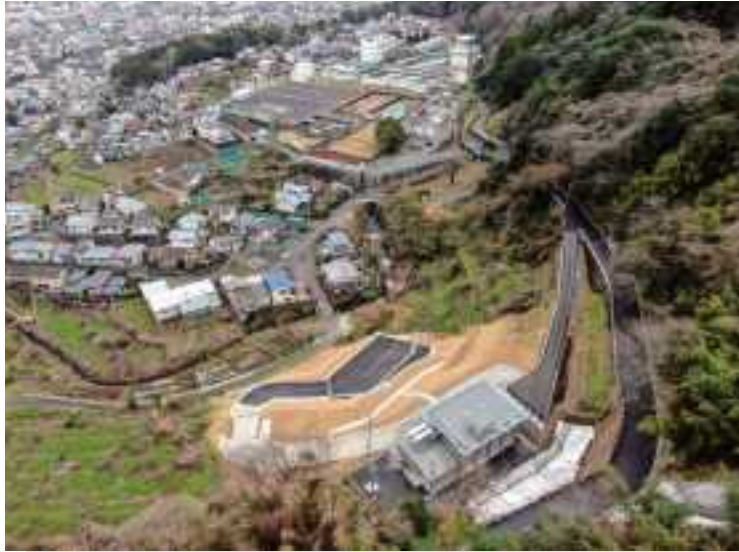
別府発電所（手前）と別府市朝見浄水場（後方）
