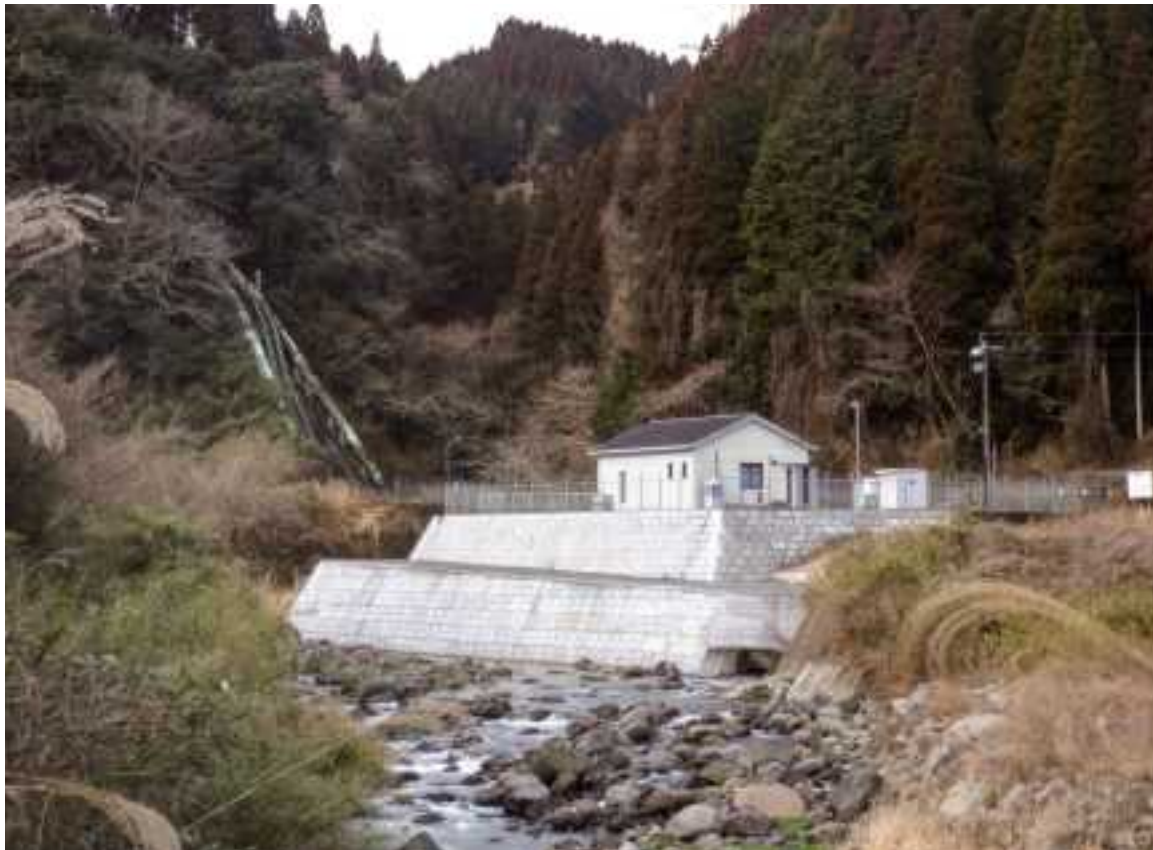
阿蘇野川発電所
