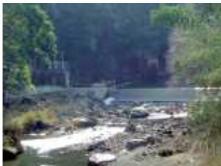
三重川取水堰
