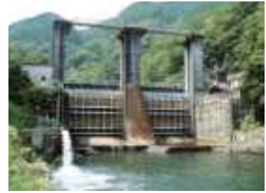
逆調整池ダム
