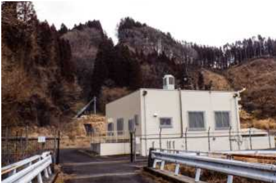
鳴子川発電所
