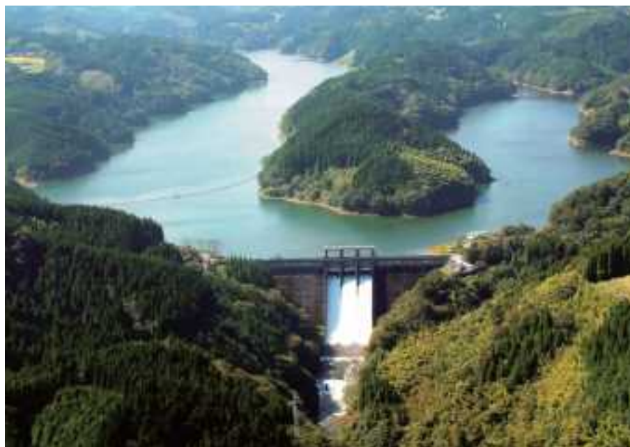
芦川ダム（左岸：竹田市、右岸：大分市）
