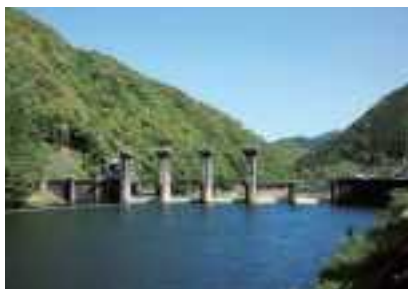
下赤逆調整池ダム
