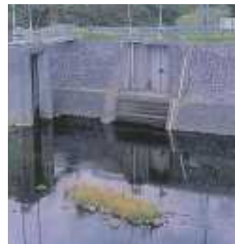
鳴子川取水堰
