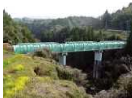
三重川水管橋
