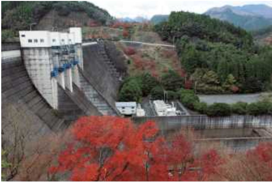
耶馬溪発電所
