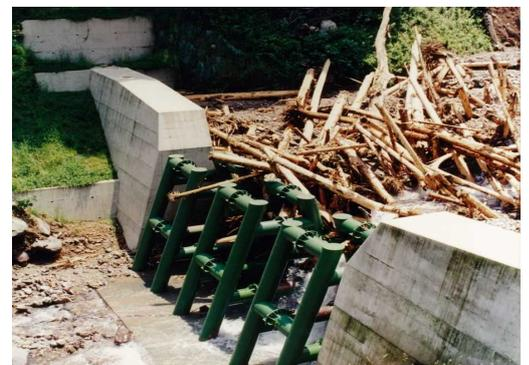
災害で発生した流木を防ぐ捕捉式ダム
