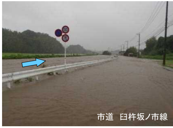
熊崎川浸水写真(H23年9月)
