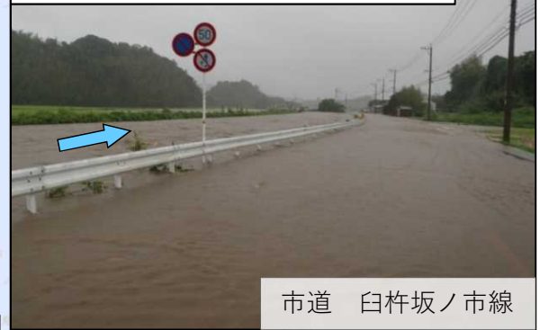
熊崎川 浸水状況 (H23.9)
