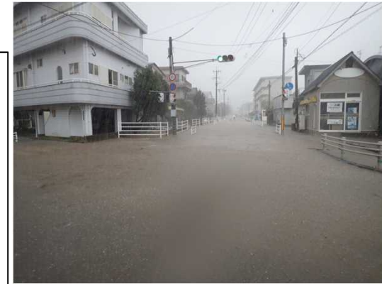
平成29年9月17日台風18号による内水被害
