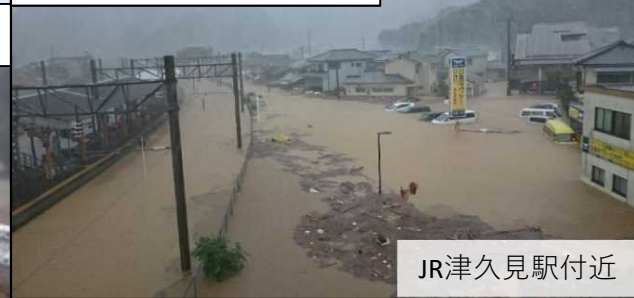
被災状況 (H29.10)
