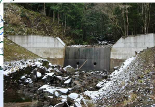
土砂を捕捉した治山ダム
