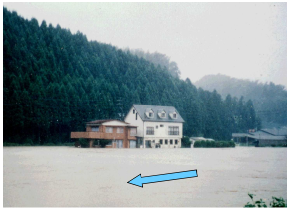
臼杵川浸水写真(H9年9月)
