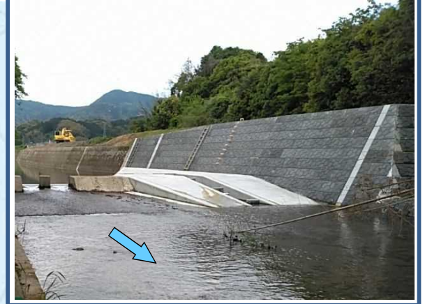
熊崎川(整備中写真)
