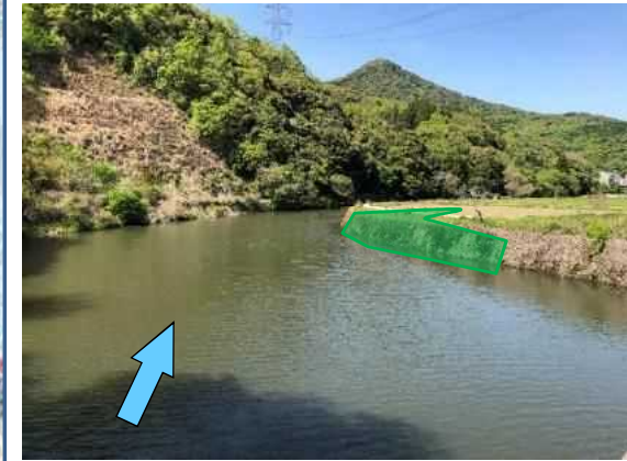
臼杵川(今後整備区間)
