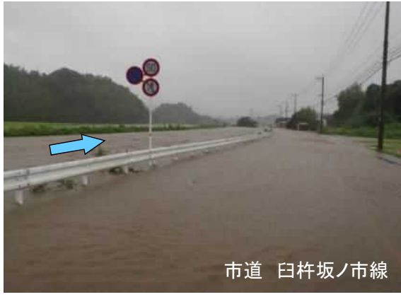
熊崎川浸水写真(H23年9月)
