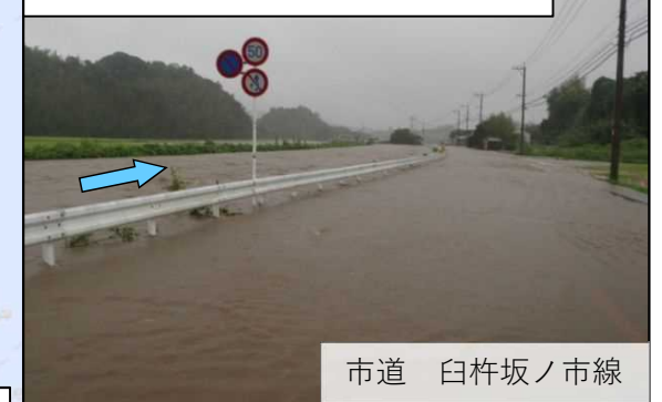
熊崎川 浸水状況 (H23.9)
