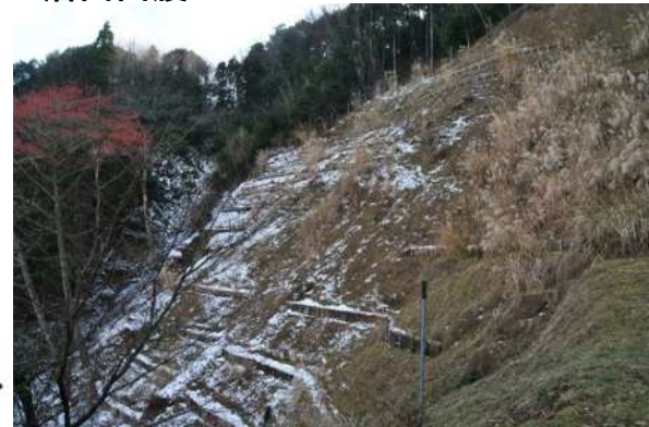
土砂を捕捉した治山ダム
