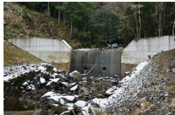
土砂を捕捉した治山ダム
