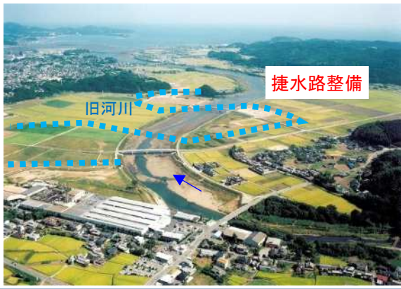
八坂川(整備済区間)
