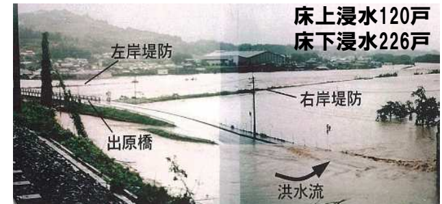
八坂川浸水写真(H9年9月)
