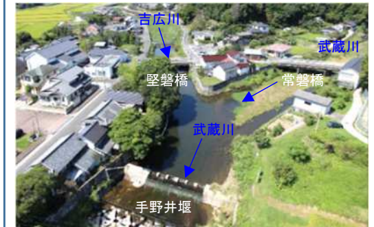
武蔵川(整備中状況写真)
