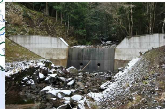
土砂を捕捉した治山ダム
