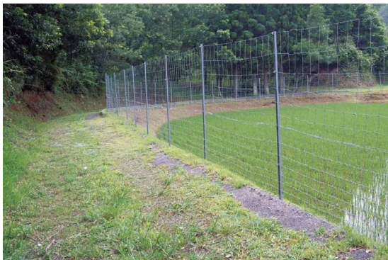
侵入防止柵の設置
