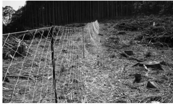
シカの防護柵 - スカートタイプ
