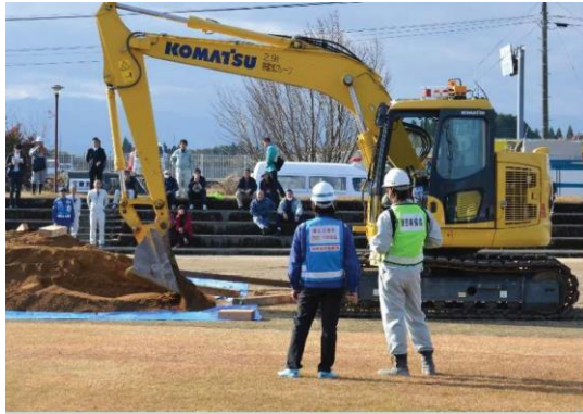
重機による障害物の除去
