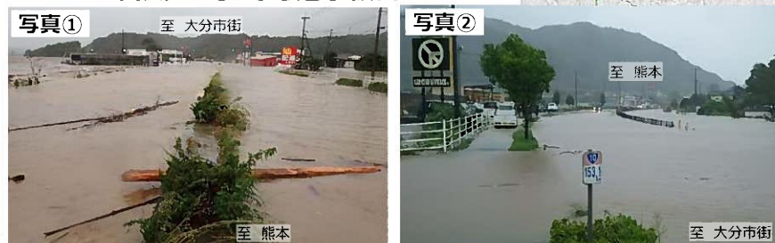
▼H29.9台風18号による冠水被害
