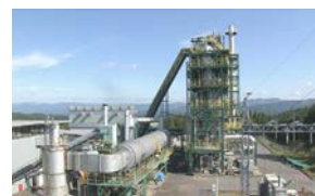
木質バイオマス発電所(日田市)
