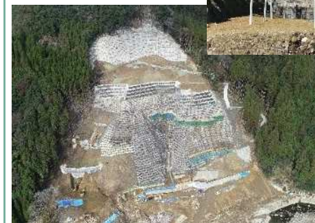
↑ 山腹工と 地すべり防止工事
