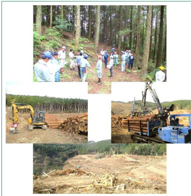
県営林の主伐地状況（植栽のための地拵え状況）
