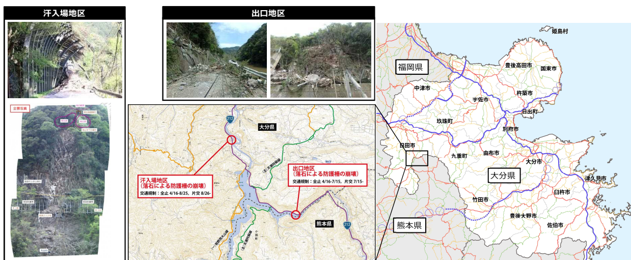
図11 熊本地震による被災状況
