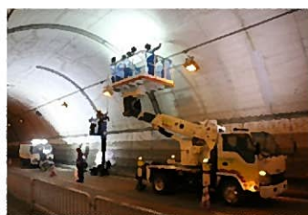
トンネル点検状況 県道竹田五ヶ瀬線（竹田市）
