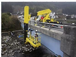
橋梁の点検状況 国道212号守実橋（中津市）
