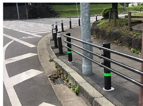
一般県道 高森竹田線（竹田市） ガードパイプ・車止め設置
