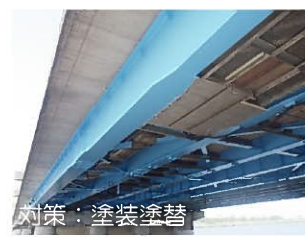
橋梁の補修状況 県道大在大大分港線 弁天大橋（大分市）
