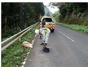
異常箇所の早期発見・補修
