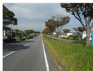
中央分離帯の防草対策
