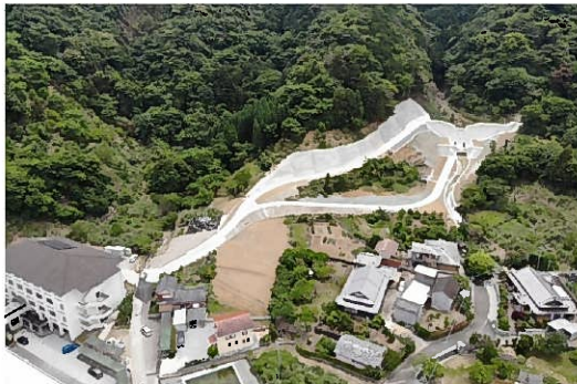
災害関連緊急砂防事業 井無田川（津久見市）
