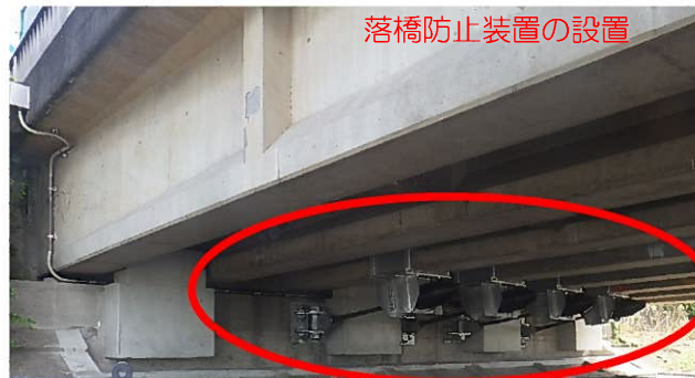
耐震補強の事例（鶴崎大南線 別保橋）
