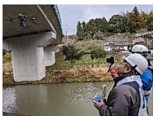
ドローンによる橋梁点検状況 県道山香院内線新秋山橋（杵築市）
