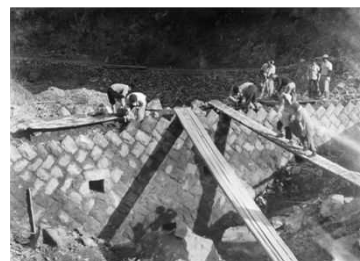
練積堰堤工の施工
