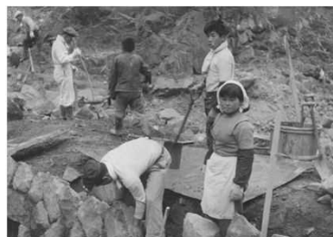
練積堰堤工の施工
