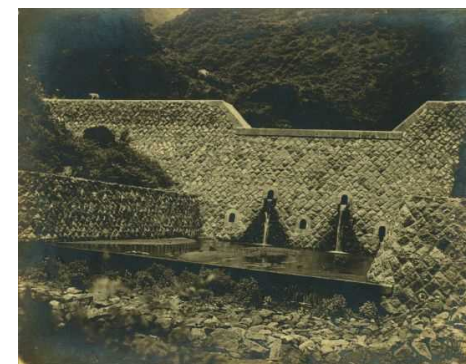
昭和初期の練積堰堤工
