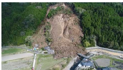
H30 中津市耶馬溪町 梶ヶ原地区
