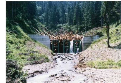
平成5年災害スリットダムによる流木捕捉
