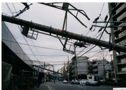
図 11 六甲道駅付近における電柱倒壊状況
