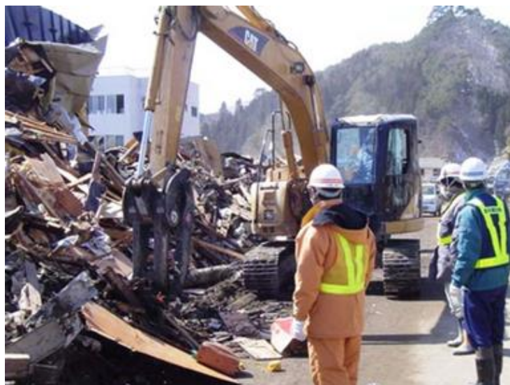
図 10 岩手県宮古市における道路啓開状況
