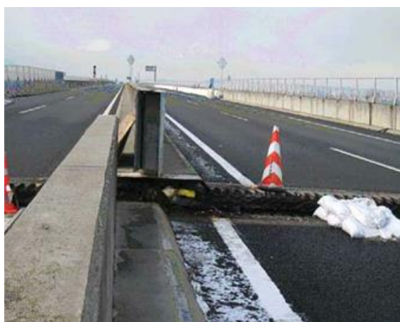
図 12 橋梁ジョイント部の土のうによる段差解消例
