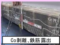
Co剥離、鉄筋露出
