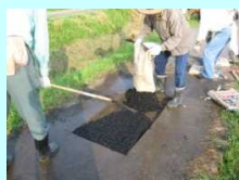
農道の部分補修
