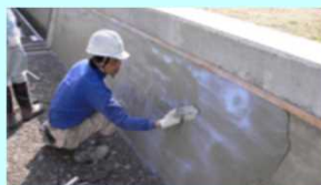
老朽化した水路壁のコーティング
