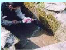
水路のひび割れ補修
