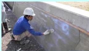
老朽化した水路壁のコーティング
