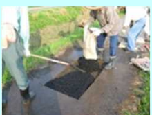
農道の部分補修
