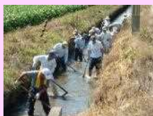
水路の泥上げ
