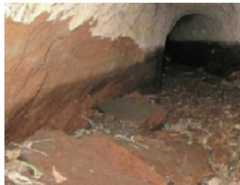
素掘水路トンネル内の崩落状況
