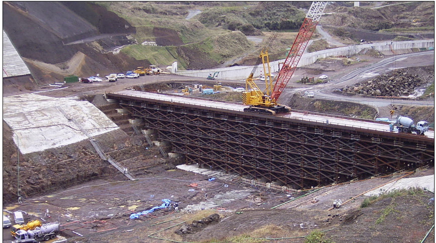
ダム本体のコンクリートを製造する設備です。
