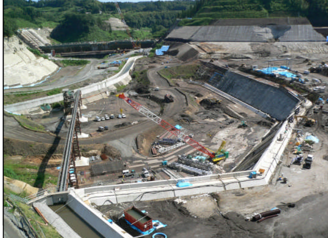
貯水池対策(1工区)工事
