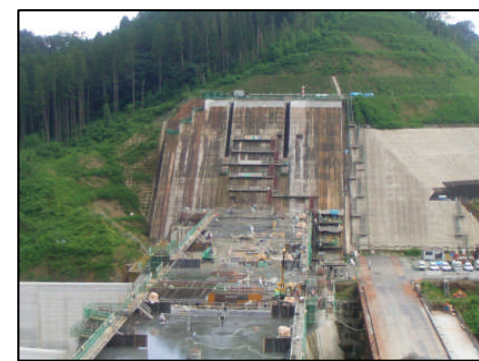
右岸造成アバット
