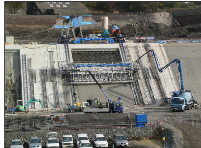
貯水池対策工事
