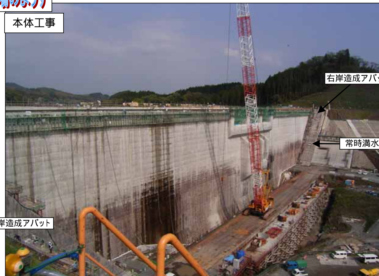
堤体コンクリート全体数量約22万m 3 のコンクリート打設が完了しました。
