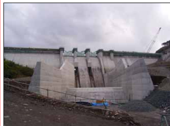
減勢工下流側状況
