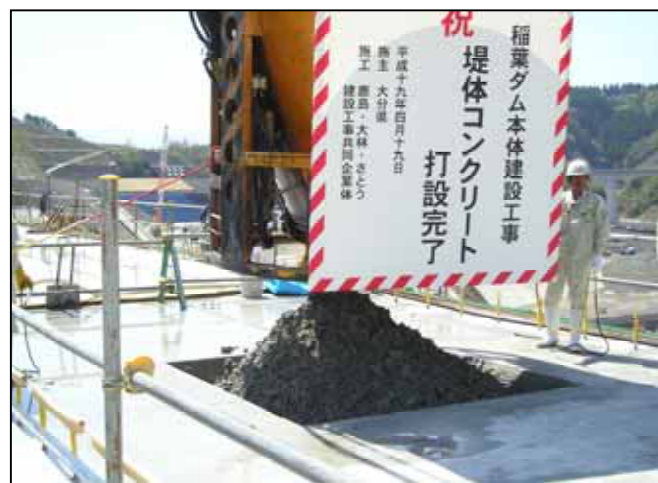
(堤体コンクリート最後の打設状況です。)
