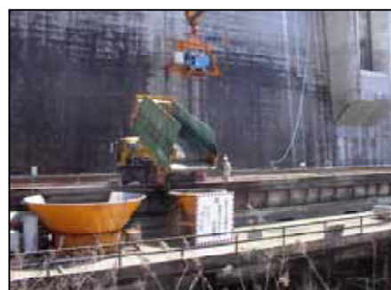
(最後の堤体コンクリートをコンクリートバケットに移しかえています。)
