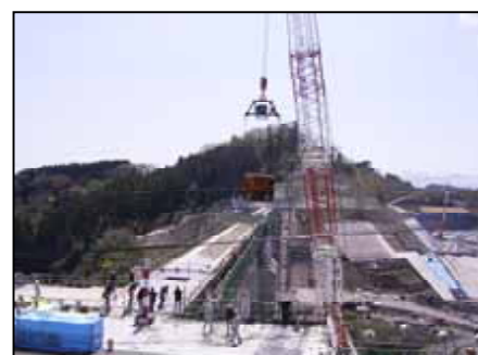
(コンクリートバケットをクレーンで打設場所まで運んでいます。)
