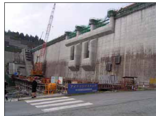
堤体上流側状況
